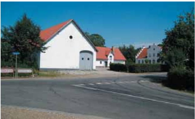
Udkørsel til Hjarup byvej fra Fløjbjergvej.
